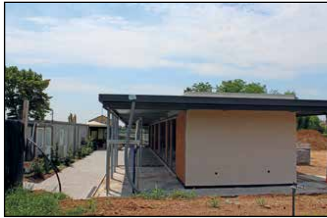
L'edificio in costruzione con di fronte l'edificio da demolire.
